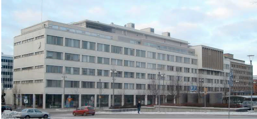
Näkymä Keskustorille v. 2009. Katolla uusi iv-konehuone.
