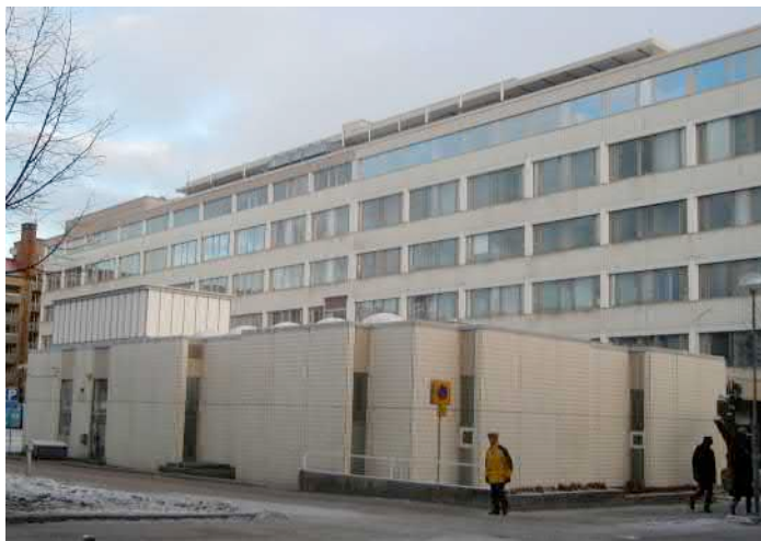
Näkymä Puutarhakadulle v. 2009. Matalan osan katolla uusi iv-konehuone.
